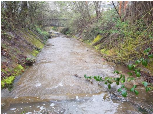
Figure 11 Dorfbach : vue sur l'extrémité supérieure du tronçon
